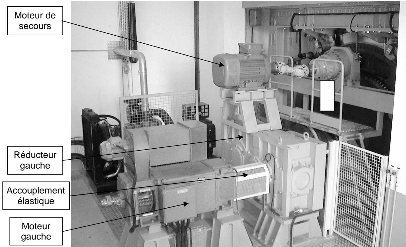
Photo 5 : Salle des machines côté gauche
